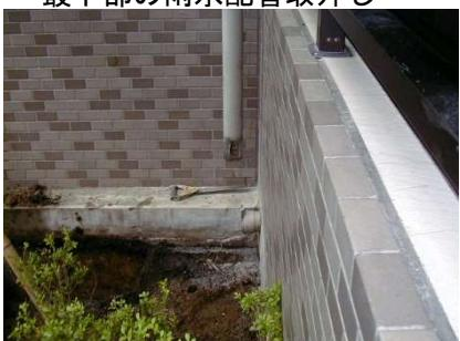
雨水立て管と1階雨水配管を分離
