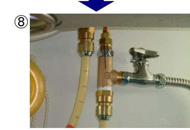
緩む恐れのある水栓と三方分岐間に油性マジックでマークングを行う。(写真はテープ)
