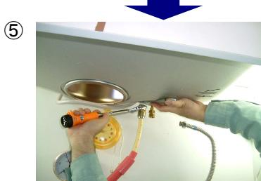
シンクをカウンターに固定し、シンク下配管の接続を行う。
