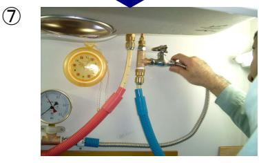
丘組みした三方分岐をシンク下配管に固定する。
