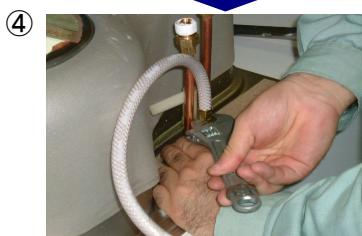
浄水器等の付属ホースを取り付ける。専用固定工具は竣工後も取付けた状態が良い。
