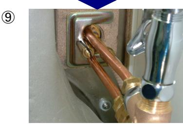
馬蹄金具固定ナットに油性マジックでマークングを行う。(写真はテープ)
