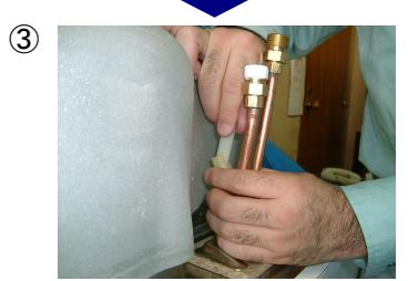
専用取付工具にて馬蹄金具締付ける。カウンター補強が十分に乾いていること。
