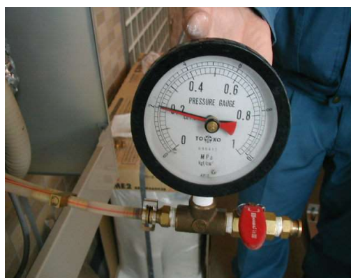
写真-2 圧力検査実施状況
