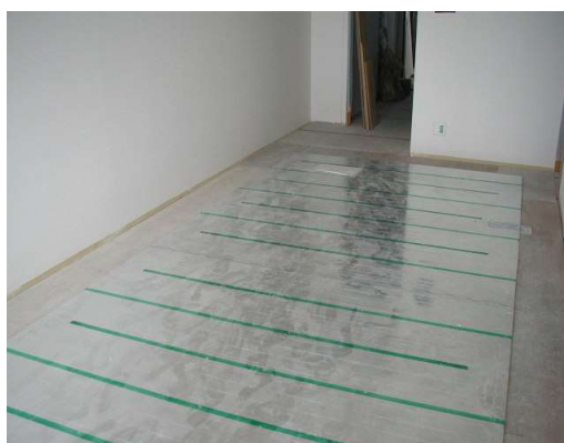
写真-1 温水式床暖房マット敷設状況
