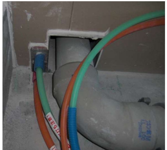
施工例（貫通ブロックと排水ブロック）
