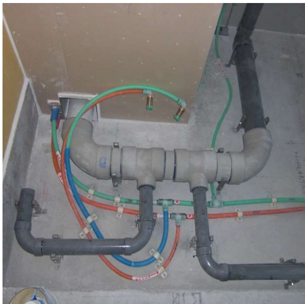
施工例（貫通ブロックと排水ブロック）
