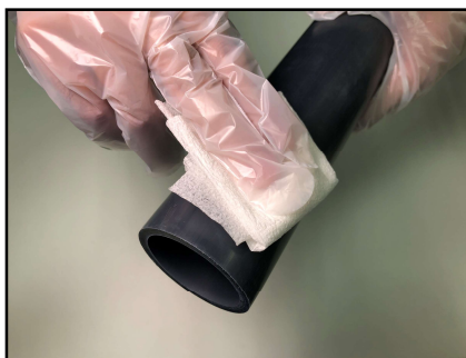
手順2: 接合面の洗浄
