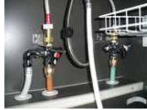
止水栓施工例
