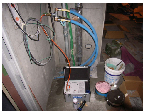
現場での検査状況
