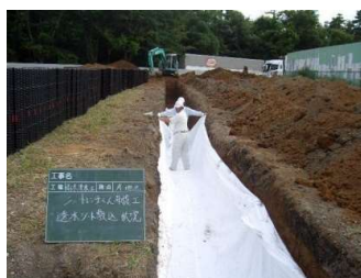
掘削・透水シート敷設
