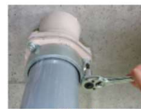
塩ビ管施工例
