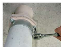
耐火二層管施工例
