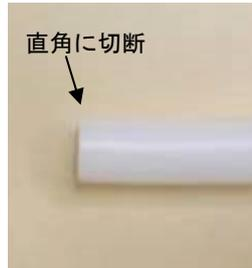
樹脂管カッターを用いて、架橋ポリエチレン管の管軸に対して直角に切断する
