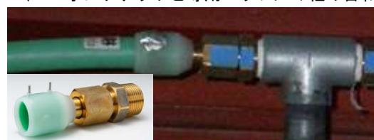
④鋼管との接続例（巻き出しプレハブ） （ユニオンソケットと専用ニップルの組み合わせ）
