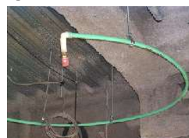
④鋼管との接続例（巻き出しプレハブ） （ユニオンソケットと専用ニップルの組み合わせ）
