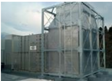
大規模タイプ対応例 (某給食センター厨房用) Q=80,000m 3 /hr
