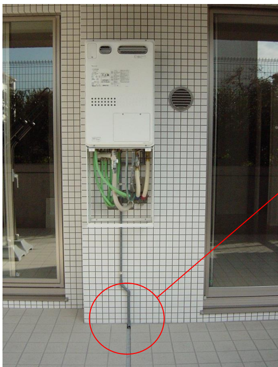
給湯器取付及び下部配管状況
