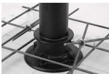
写真-1 スラブ配筋と本体結線詳細
