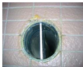
写真-6 2管路ダクトへの塩ビプレート取付状態
