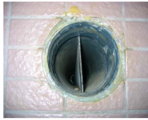
写真-2 外壁面のダクト先端部状態
