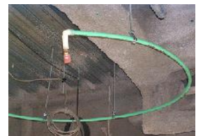
④鋼管との接続例（巻き出しプレハブ） （ユニオンソケットと専用ニップルの組み合わせ）
