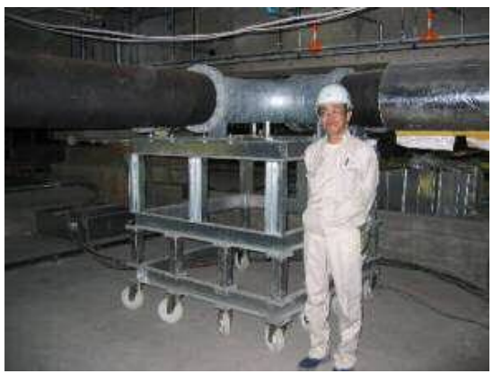
300A×400A連キャスター (施工中) 高床タイプ
