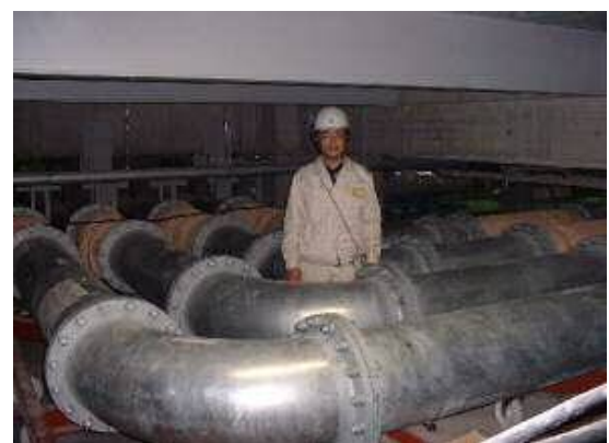
400A×4系統連キャスター (施工中) 低床タイプ
