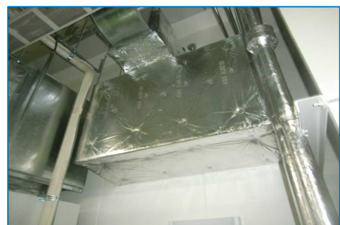
施工状況写真
