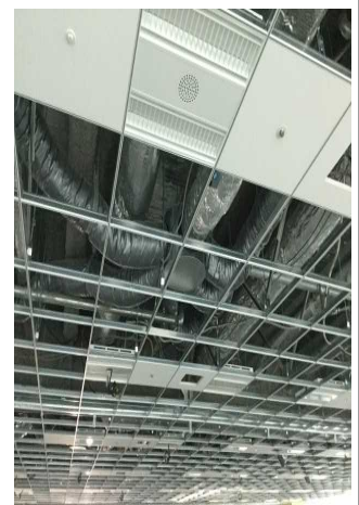
天井内施工状況
