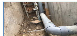
例) 建物周囲の配管工事
