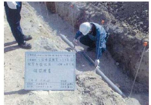
土間配管検査の例
