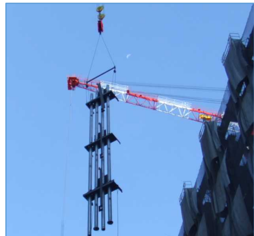
ライザー配管工法
