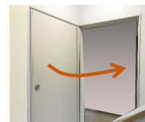
防火扉作動試験
