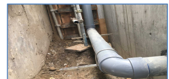
例) 建物周囲の配管工事
