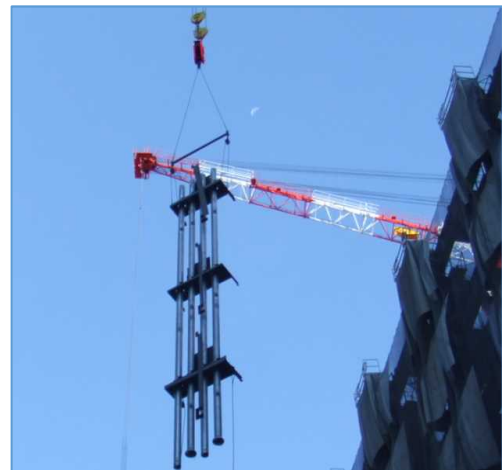
ライザー配管工法
