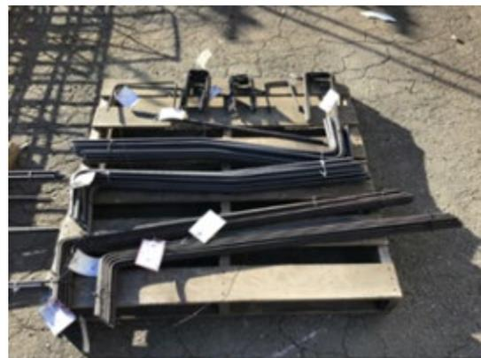
⑤自動加工機で加工後の鉄筋
