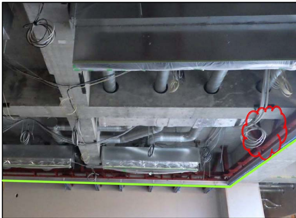
施工状況写真
