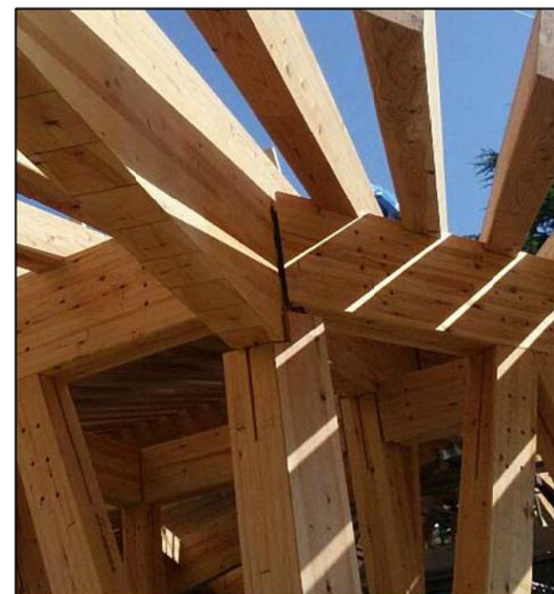
施工状況写真
