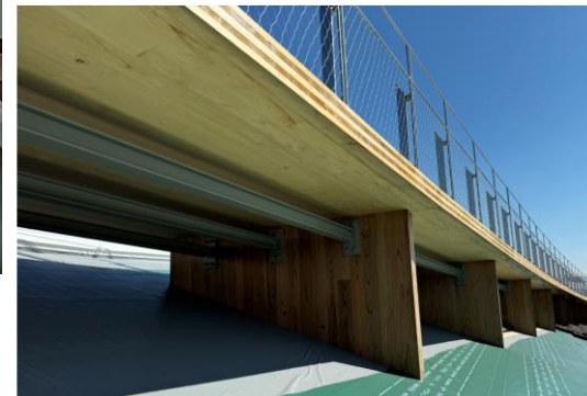
スロープ東材施工状況
