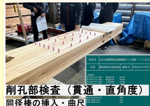
⑦上部の孔貫通
