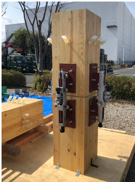
GIR工法 施工前試験状況 (柱継手部)
