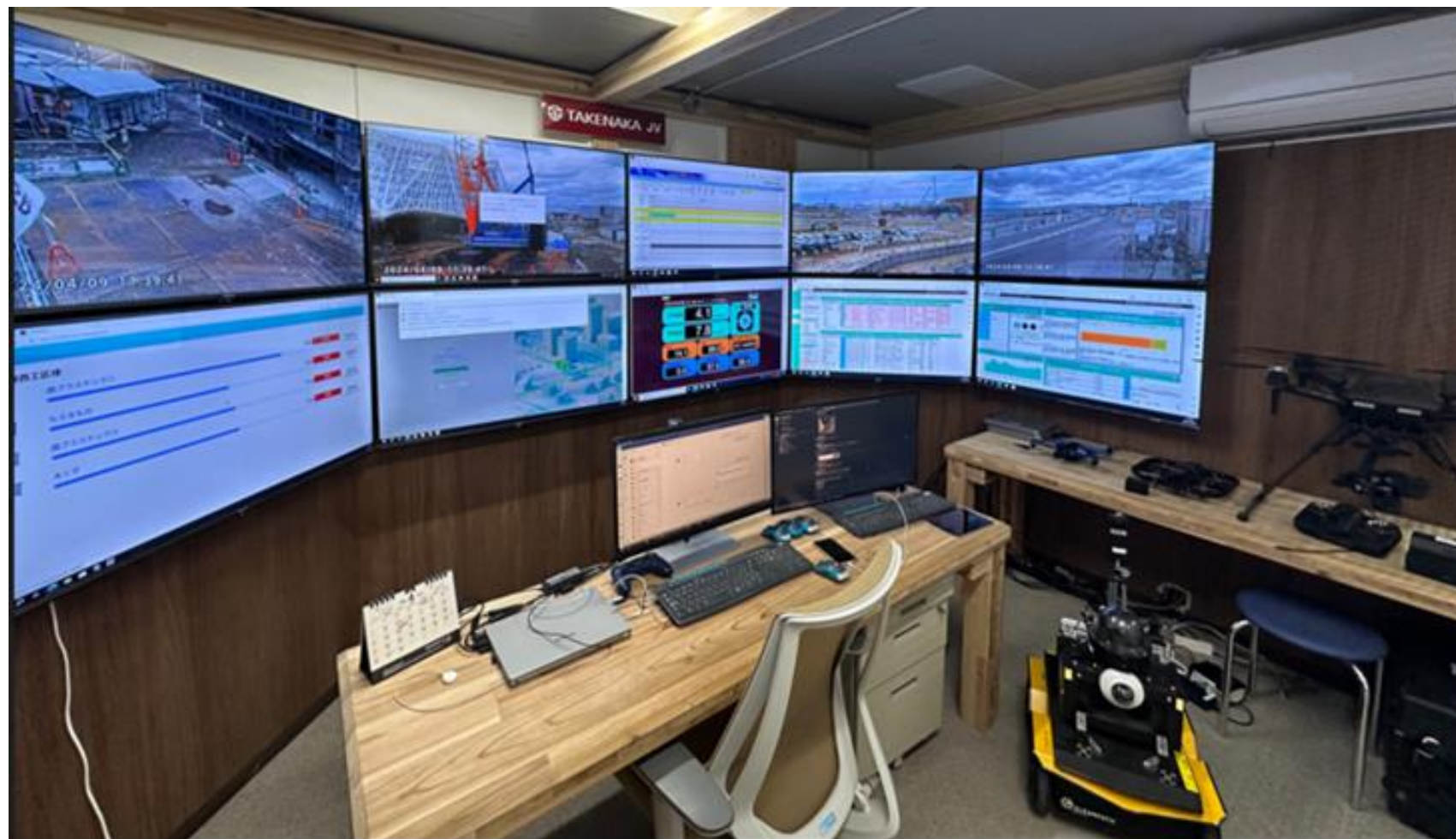
Future Roomにて工事の進捗管理を実施
