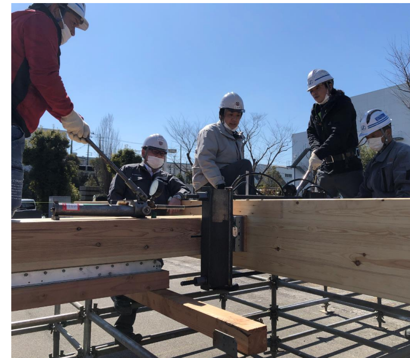
柱梁仕口部の鉄楔打ち込み試験状況
