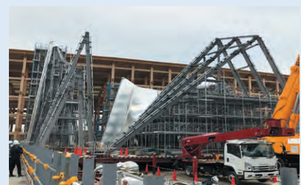
鉄骨建方の状況
