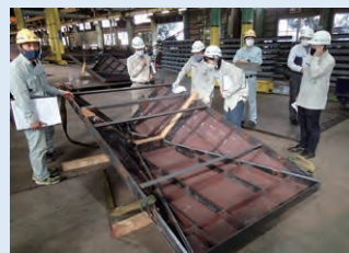
熱橋対策確認
