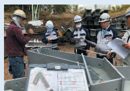
BIMモデルを用いた鉄骨仮組検査
