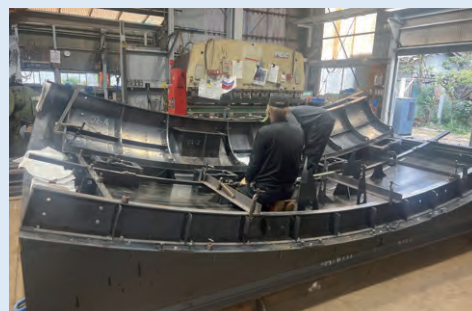
PC鋼製型枠
