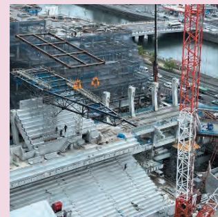
屋根鉄骨ユニット揚重状況
