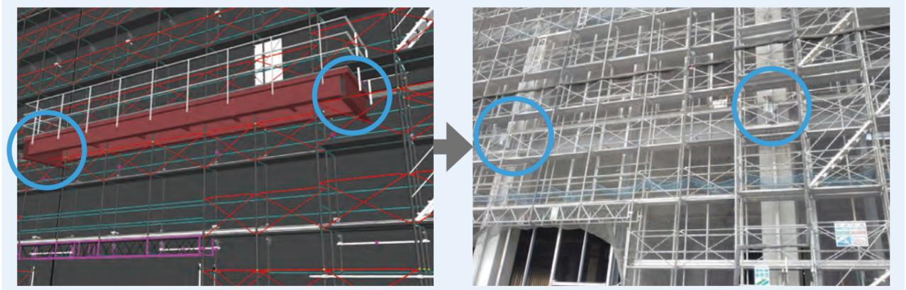
後施工の梁を事前課題解決 (支柱を躲した足場の割り付け) 実際の現場における組み立て写真
