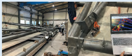
工場仮組検査におけるBIMモデル活用
