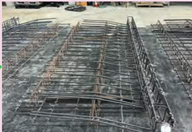
⑤組み立て後の鉄筋
