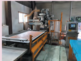
< パネル加工 > 型枠展開図作成ソフト会社の持つ 型枠加工工場にて型枠を加工
