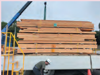
&lt; 型枠材現場搬入 &gt;
