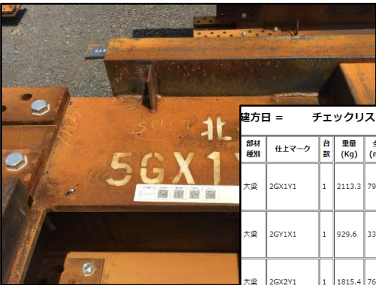
QRコードで鉄骨部材を管理した事例
