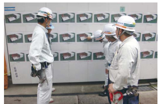
朝礼会場での施工手順の掲示
