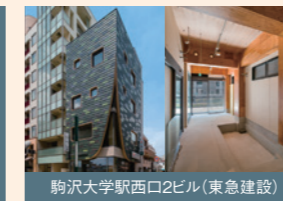
駒沢大学駅西口2ビル(東急建設)
