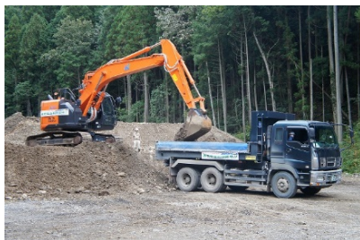
省燃費運転研修会 (実技:桜川ダム本体建設工事現場)
