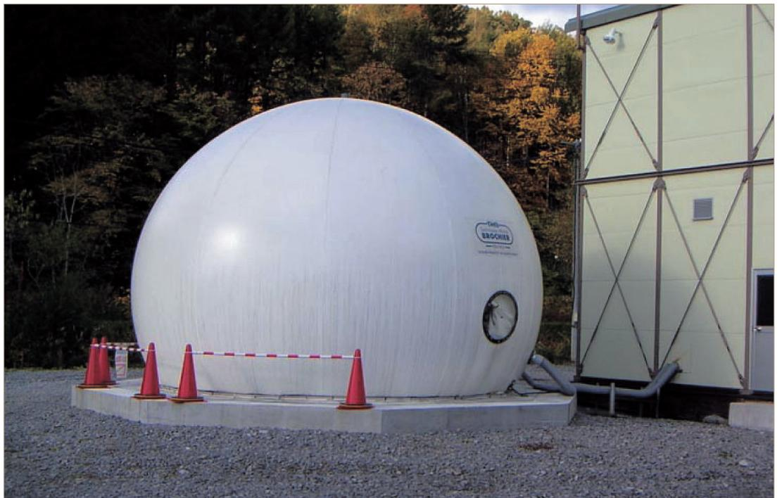
生ゴミバイオガス化発電施設に設置されたガスホルダー
