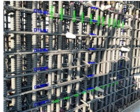
写真-4 配筋撮影（BAIAS）
