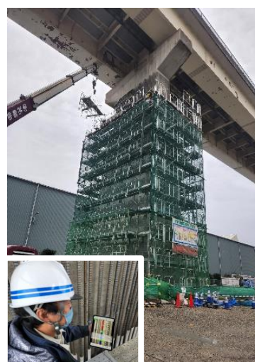
写真2 検査状況（飛島高架橋耐震工事）
