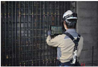
写真-1 鉄筋計測状況
