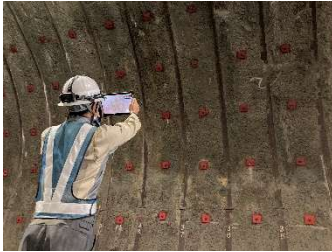
写真-2 ロックボルト間隔検測状況
