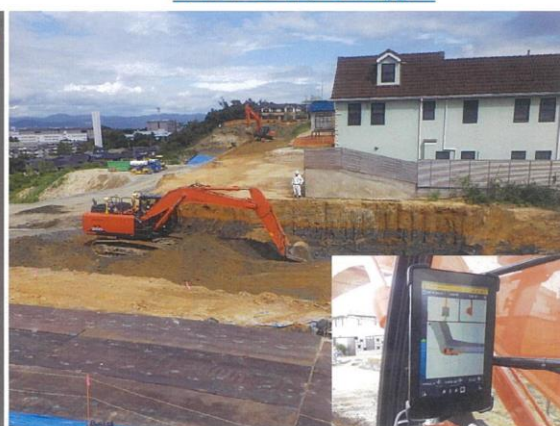
マシンガイダンス施工
