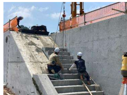
図2 階段ブロック敷設状況
