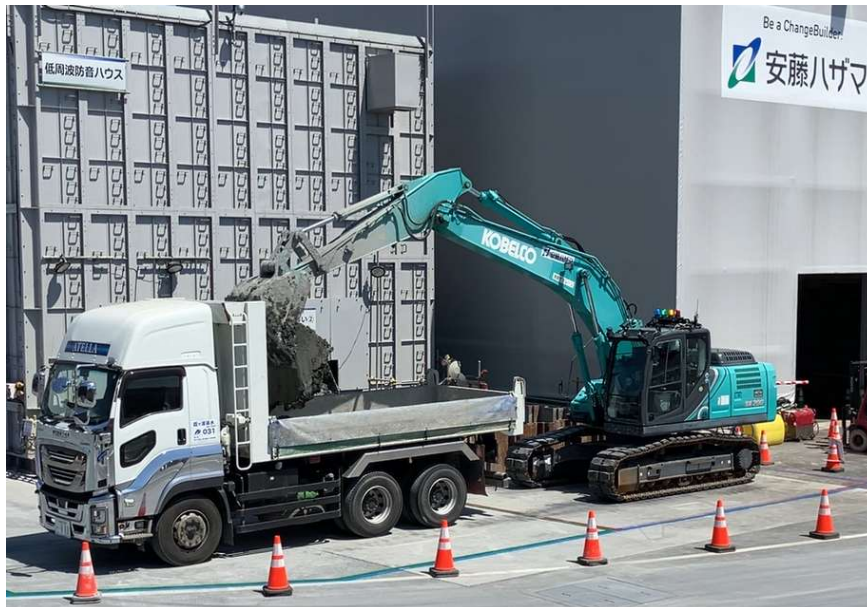
図-2 実現場での土砂積込み作業
