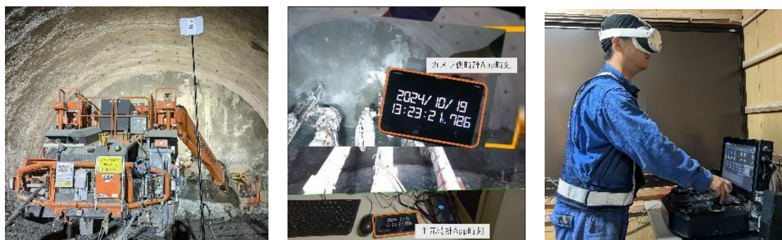
図-3 トンネル現場導入状況
