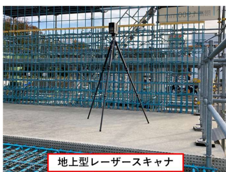
写真-1 点群データ取得作業
