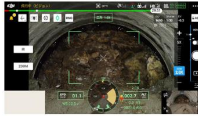
発破後の切羽全景
