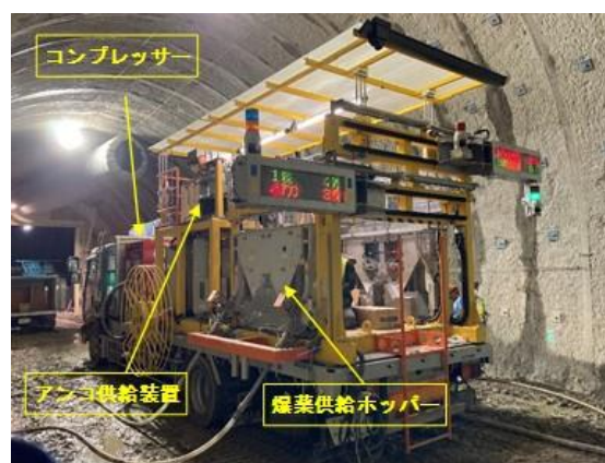
写真 1 遠隔装填装置
