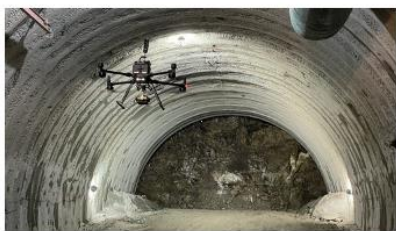
発破後の切羽点検
