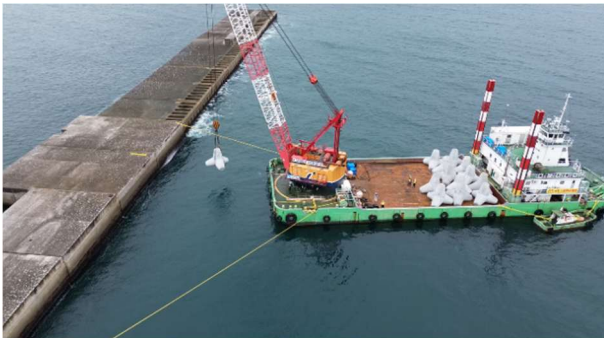
写真1 消波ブロック据付状況
