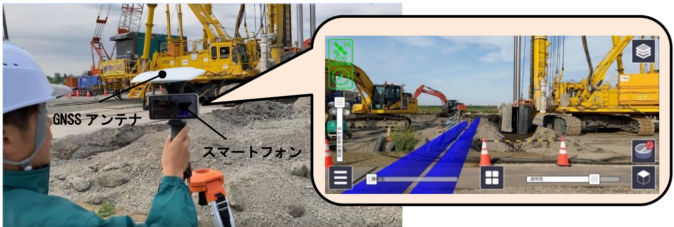
写真-1 地盤改良時 AR 使用状況
