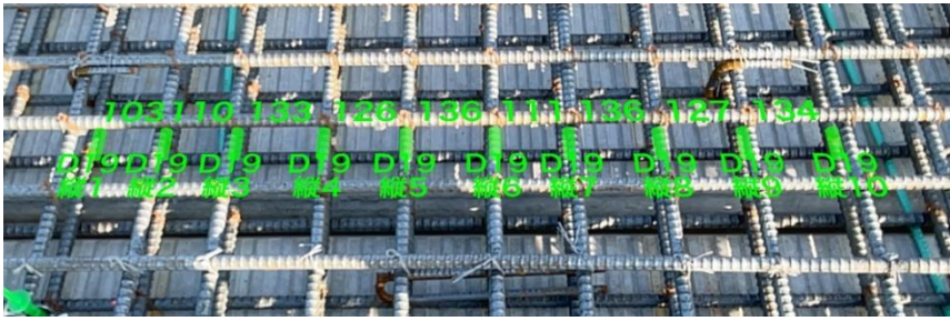
写真-1 ダブル配筋（下縁鉄筋）の計測状況
