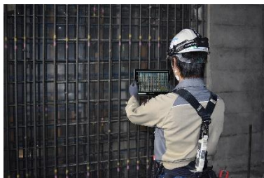
写真-1 鉄筋計測状況
