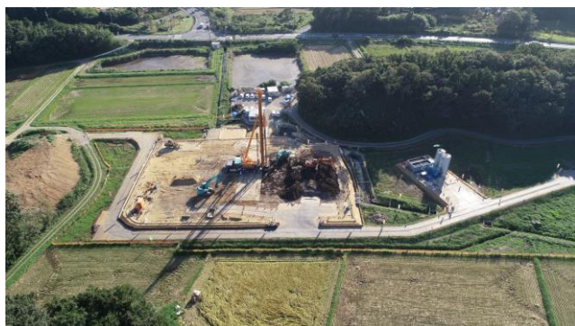
写真-1 施工状況
