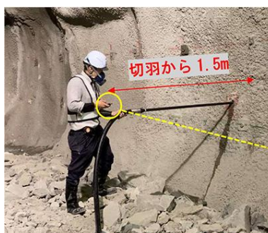
写真2：本装置を適用した装薬状況
