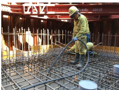
写真2 ホロレンズ装着による締固め作業状況
