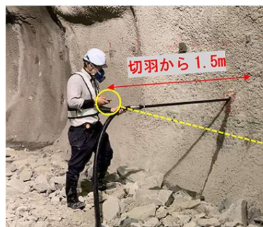
写真2：本装置を適用した装薬状況
