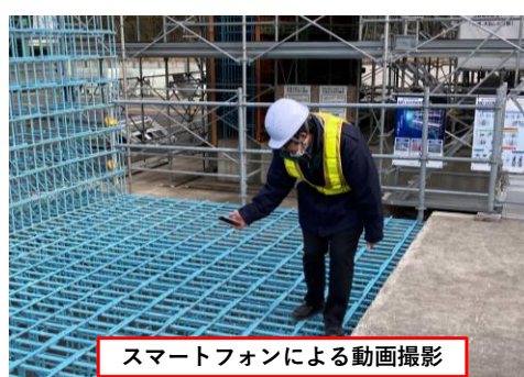
写真-1 点群データ取得作業
