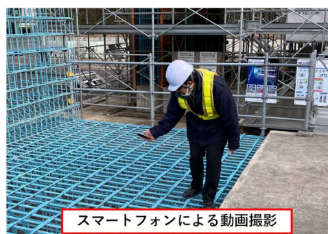
写真-1 点群データ取得作業
