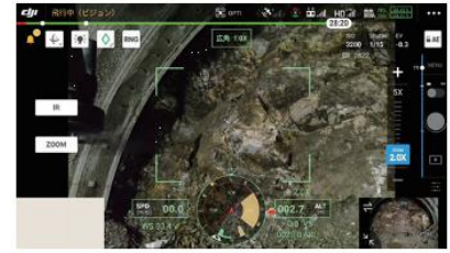
発破後の切羽ズーム
