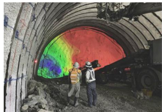
写真 2 岩盤強度分布断面の切羽投影状況
