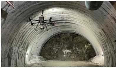
発破後の切羽点検
