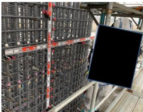
写真-3 配筋撮影（従来）
