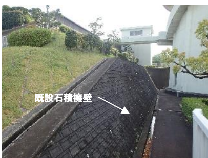
写真 1 法面保護工施工箇所
