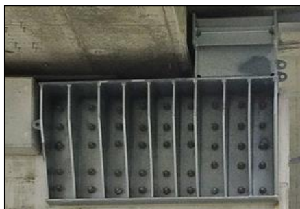
写真-1 上：アンカー設置状況 下：ブラケット設置状況
