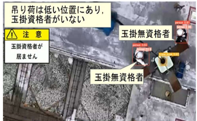
図4 玉掛作業無資格者による作業の検知例
