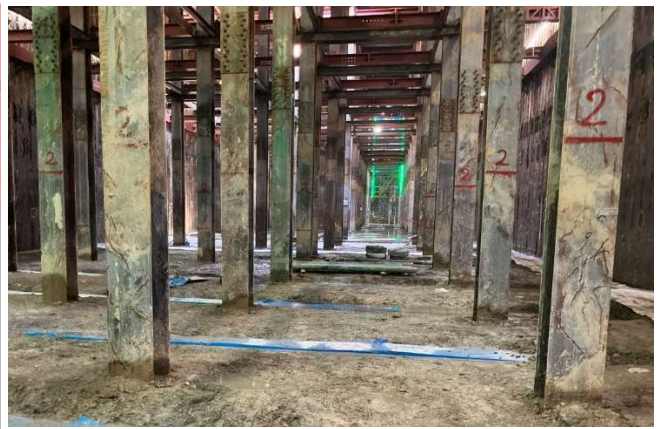
写真 1 現場状況 (実施工)
