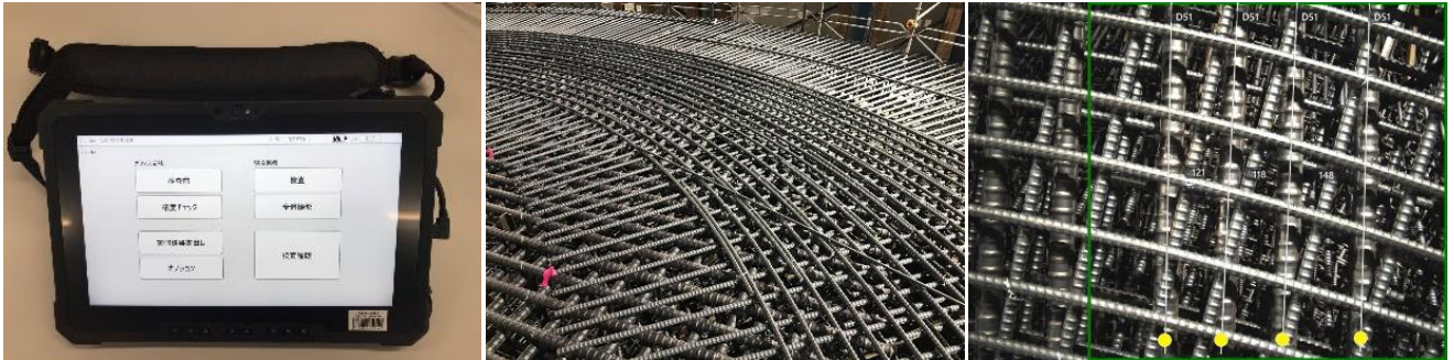
写真 2 AI 配筋検査端末 FieldBar 写真 2 底版配筋写真（遠景） 写真 1 底版配筋写真（FieldBar）
