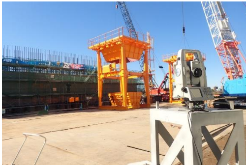
写真1 TS計測状況
