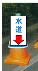
写真 1 埋設物の見える化（従前）
