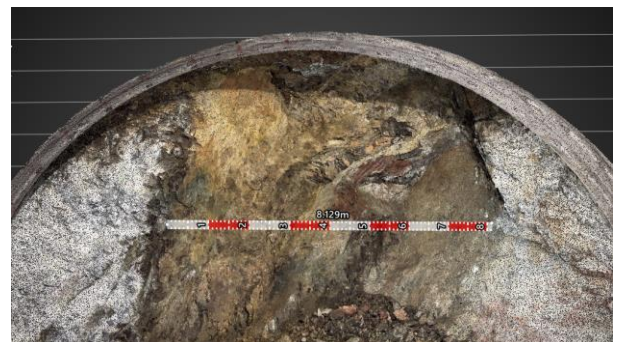
図-4 崩落幅を計測
