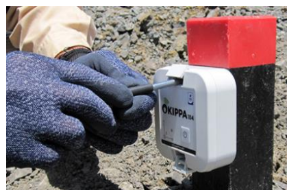
写真-1 センサボックス設置状況
