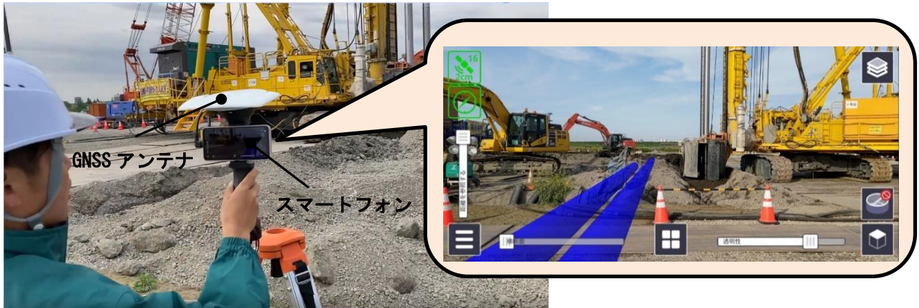
写真-1 地盤改良時 AR 使用状況
