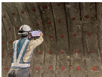
写真-2 ロックボルト間隔検測状況
