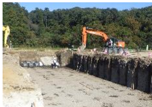
写真-2 自動打設による改良杭の掘り起こし状況
