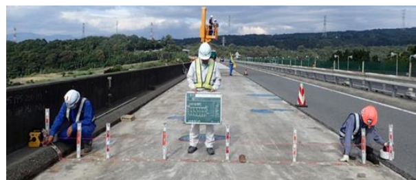
写真-1 従来の舗装出来形測定
