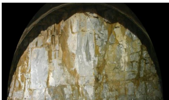
図-3 AI により亀裂を可視化結果の一例
