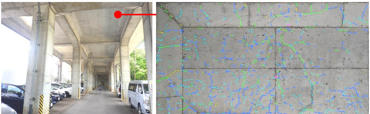
図2 点検コストを比較したラーメン高架橋の外観と t.WAVE によるひび割れの検出結果
