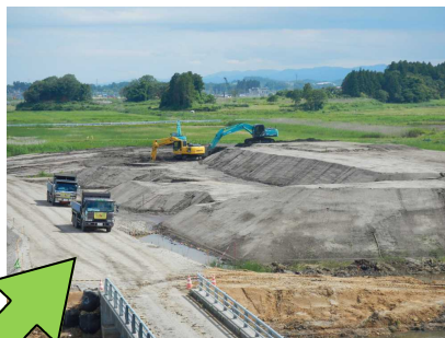
新地町磯山地区 再生資材受入状況
