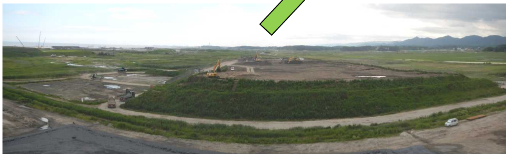
新浜の再生資材仮置場の状況
