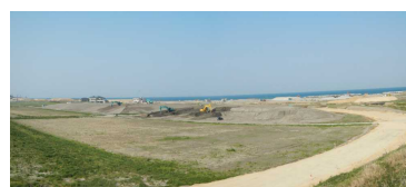
新地町へ再生資材運搬
