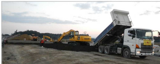
堤防工事への再生土砂搬入状況
