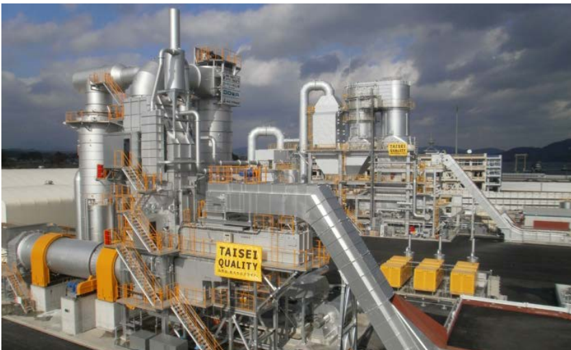
(写真：手前がロータリーキルン炉・奥がストーカ炉)
