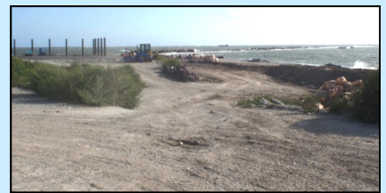
南浜 (混合廃棄物搬出完了)
