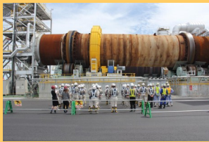
完成したJ2焼却炉に向かって安全祈願
