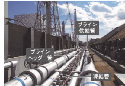
福島第一原子力発電所陸側遮水壁 (凍土壁)
