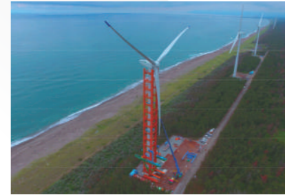
三種浜田風力発電所建設プロジェクト
