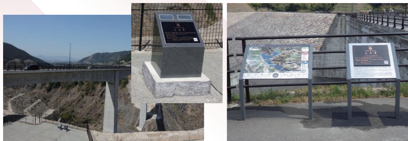
国道325号阿蘇大橋上下部工事（新阿蘇大橋渡可部）（第2回土木賞受賞）
