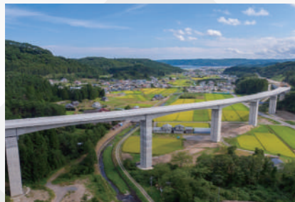
国道45号夏井高架橋工事におけるi-Bridgeの取組み
