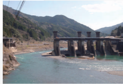
荒瀬ダム本体等撤去工事
