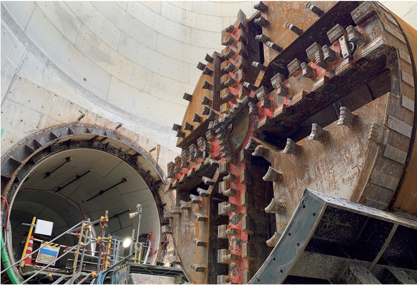
シールド機到達状況 Shield tunneling machine reaching the arrival point
