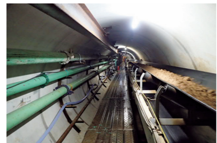
工事用トンネル内部 Inside view of the construction tunnel
