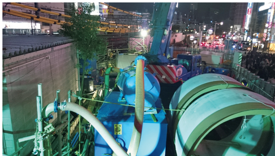
トンネル掘削推進施工状況 Tunnel boring
