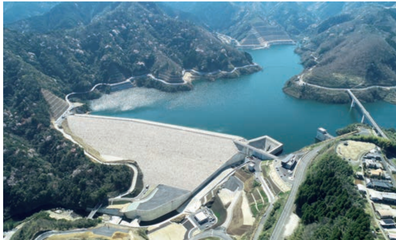
下流側から見た全景 Panoramic view from downstream side
