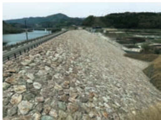
洪水吐 呑口部施工完了(上)、ロックフィルダムの傾斜部リップラップ(下) Flood spillway intake port work completed (top) and riprap at slope of rock-fill dam (bottom)
