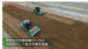
3機種が連携して稼働している仕組み(クワッドアクセル) Mechanism operating by linking 3 models (A4CSEL)
