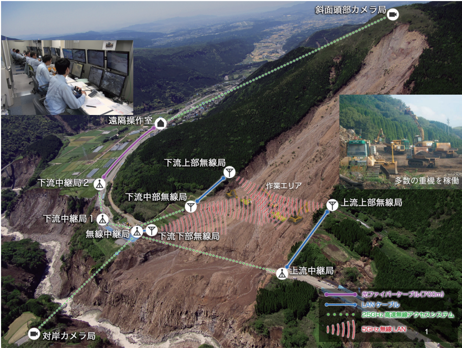
ネットワーク対応型に高度化した無人化施工技術 Advanced unmanned construction technology to support networking
