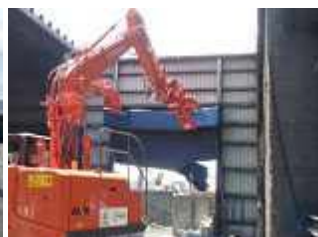
シャッター解体
