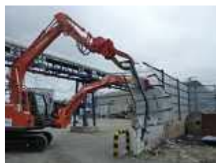
フェンス解体
