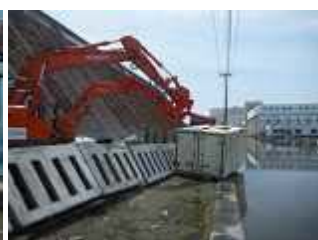
コンテナ車解体
