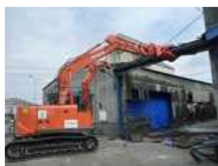
シャッター解体
