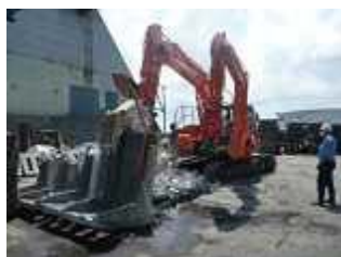
消波ブロック撤去
