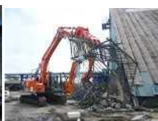
フェンス撤去
