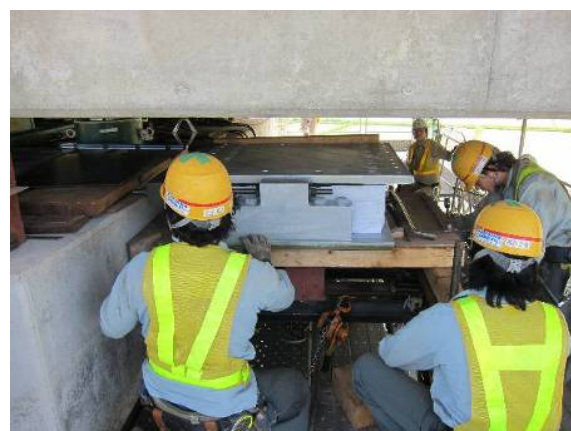
支存取替状況
