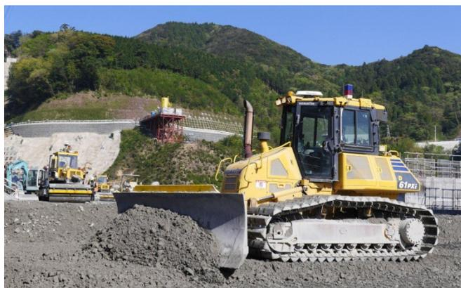
自動ブルドーザによるRCDコンクリートの撒き出し作業
