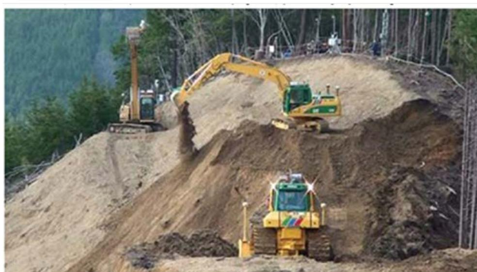
遠隔操作式バックホウ、ブルドーザによる河道閉塞緊急対策工事
