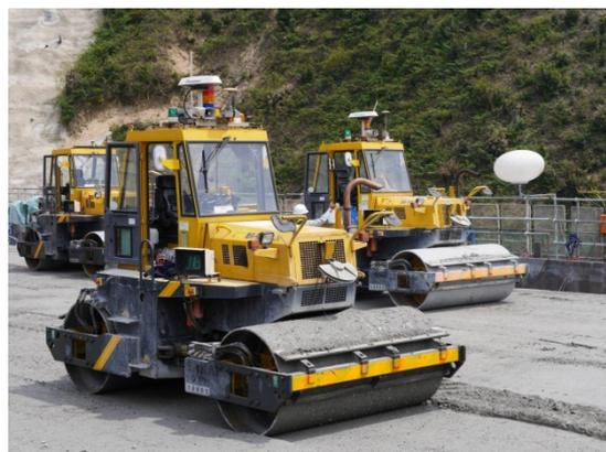
自動振動ローラによる転圧作業
