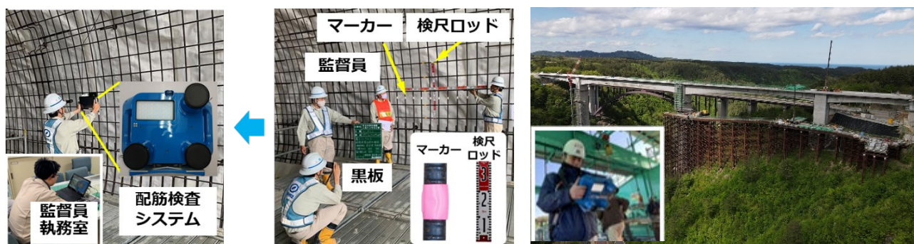
(a) システム利用した遠隔臨場 (b) 従来検査 写真 1 配筋検査比較
