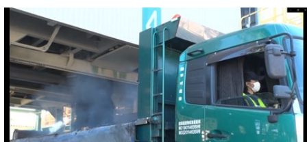
②ダンプトラックに As 合材積込
