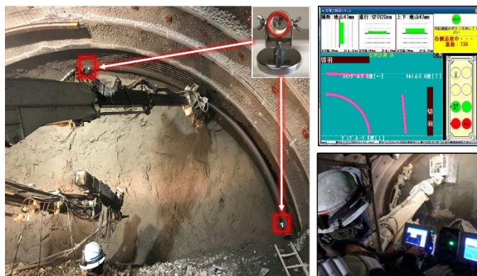
写真-2 ナビゲーションによる位置合わせ状況
