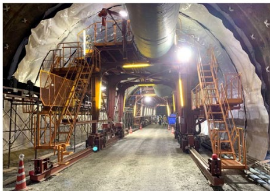
写真-1 Rail Walker System の現場適用『福島県博士トンネル工事(昭和村側工区)』
