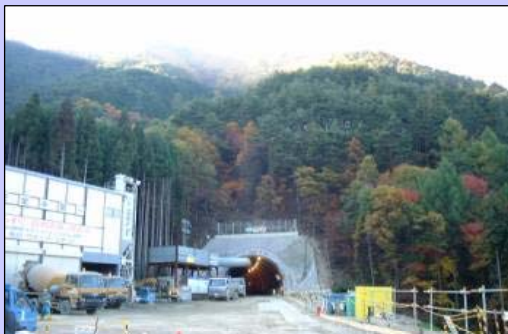
デジタルカメラ調査トンネル坑口全景
