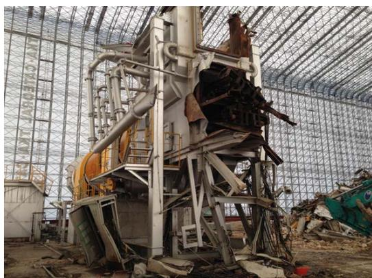
写真-25 仮設焼却炉の解体状況
