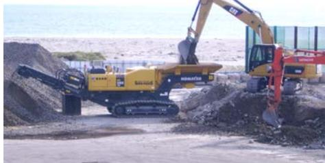
写真-7 コンクリートくず破碎状況(宮城県:名取処理区)
