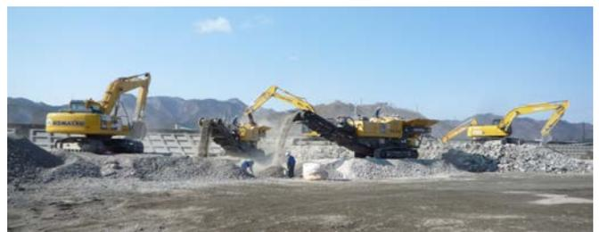
写真-2 コンクリートくずの破碎状況（岩手県：大槌地区）
