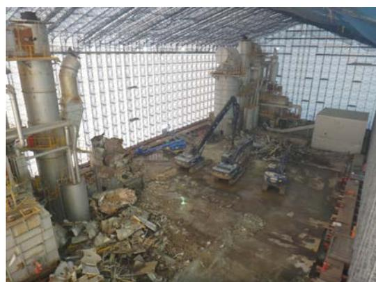
写真-26 仮設焼却炉の解体状況
