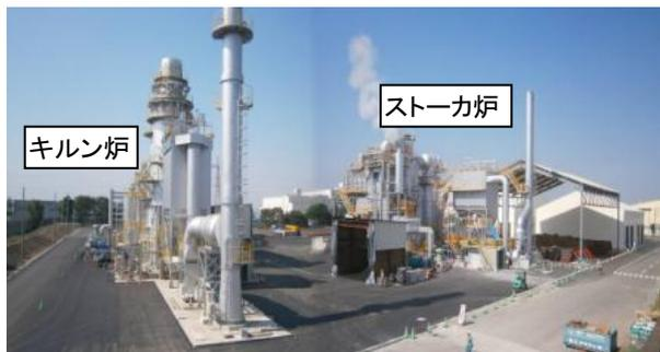
写真-14 稼働中の仮設焼却炉（宮城県：宮城東部ブロック）
