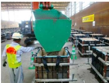
写真-24 アップサイクルブロック打設状況
