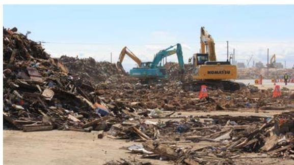
写真-9 重機による粗選別状況(宮城県:石巻ブロック)
